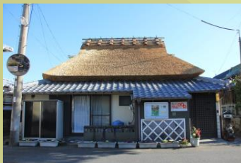
↑「かやぶき心 本部」外観 かやぶき屋根の建物が目印です。
